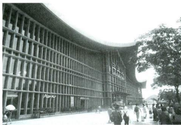
写真23 波をイメージして作られた海南東・西環鉄道の勇壮な三亜駅舎
