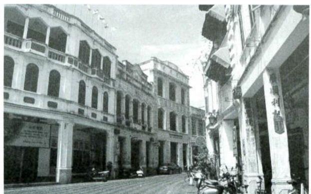
写真19 西欧様式の影響が残る海口騎楼老街
